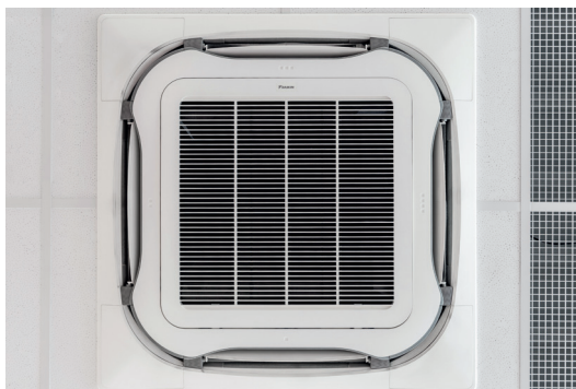
Samočisticí kazetová jednotka s kruhovým výdechem má menší požadavky na údržbu a vydrží déle čistá.
