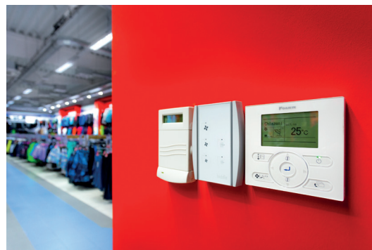
Systém je centrálně ovládaný díky použití Daikin Intelligent Touch Manager.
