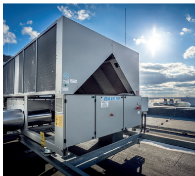
4 chladicí jednotky Daikin zajišťují chlazení pro laboratoře a výrobní mikroskopy.
